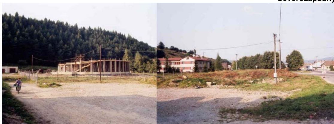
Pohľad na centrálnu časť obce s rozostavaným objektom kostola
